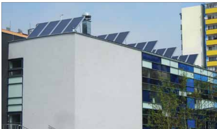
Kolektory płaskie zbudowane na dachu poziomym pływalni krytej
