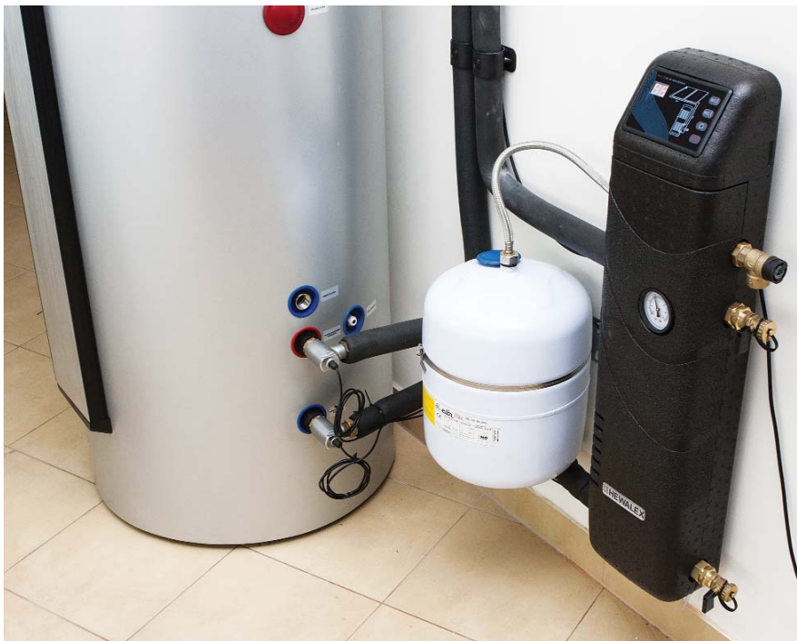
Rys. 3. Zespół pompowo-sterowniczy Hewalex ZPS18a-01 ze sterownikiem G425. Podłączenie zespołu ZPS do węzownicy podgrzewacza (pompa ciepła c.w.u.: Hewalex PCWU200K-2,3kW) z tulejami do zabudowy czujników temperatury dla funkcji Opti-Flow
