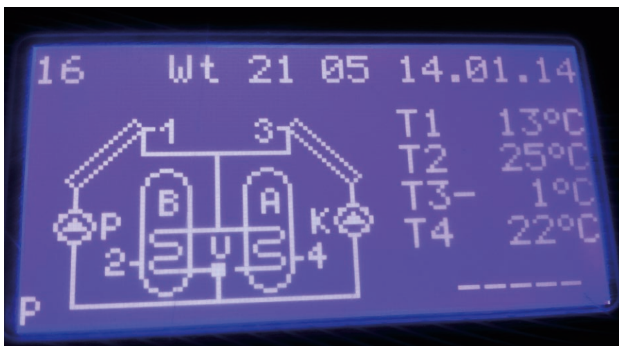
7. Widoczny w porze wieczornej dnia zimowego (14 stycznia, godz. 21:05) przepływ grawitacyjny glikolu w jednej z baterii kolektorów słonecznych. Pomiar temperatury przez czujnik nr 1 wskazuje na +13°C
