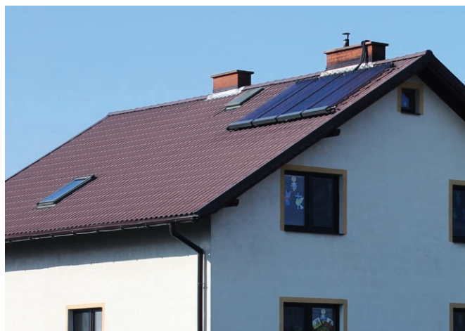
3. Między baterią kolektorów słonecznych a krawędzią dachu powinno się zapewnić odpowiedni odstęp. Ważne jest też, aby przy dłuższej pości dachu nad baterią pamiętać o stosowaniu barierek przeciwnieogowych
