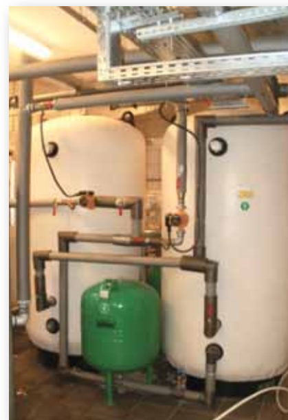
Fot. 2. Priorytetem pracy instalacji solarnej powinno być uzyskiwanie jak najwyższej efektywności wyrażanej jednostkowym uzyskiem ciepła ( \text{kWh/m}^2\text{rok} ), wobec czego w pierwszej kolejności przewidywane jest podgrzewanie wody basenowej (z lewej: wymienniki ciepła płaszczowo-rurowe dla wody basenowej), a dopiero później podgrzewanie wody użytkowej (z prawej: zasobniki wody)
