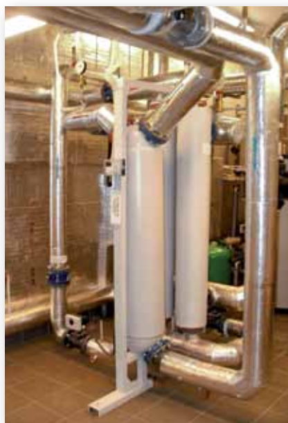
Fot. 2. Priorytetem pracy instalacji solarnej powinno być uzyskiwanie jak najwyższej efektywności wyrażanej jednostkowym uzyskiem ciepła ( \text{kWh/m}^2\text{rok} ), wobec czego w pierwszej kolejności przewidywane jest podgrzewanie wody basenowej (z lewej: wymienniki ciepła płaszczowo-rurowe dla wody basenowej), a dopiero później podgrzewanie wody użytkowej (z prawej: zasobniki wody)
