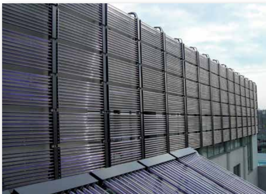
Fot. 1. Standardowo dla dużych instalacji solarnych, ze względów technicznych i ekonomicznych uzasadnione jest zastosowanie kolektorów płaskich. W uzasadnionych przypadkach znajdują także zastosowanie kolektory próżniowe specjalnej konstrukcji, uzyskujące wysoką efektywność pracy także w opcji zabudowy pionowej na elewacji budynku.
