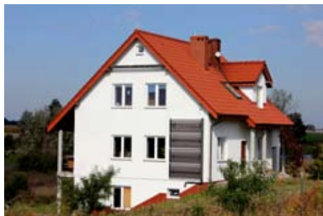
Rys. 3. Kolektory próżniowe Hewalex KSR10 pozwalają na montaż także na elewacji budynku w pozycji pionowej
