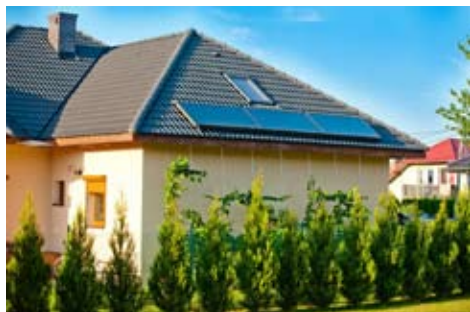
Rys. 1. Kolektory płaskie z absorberami harfowymi pozwalają na montaż w dowolnej pozycji
