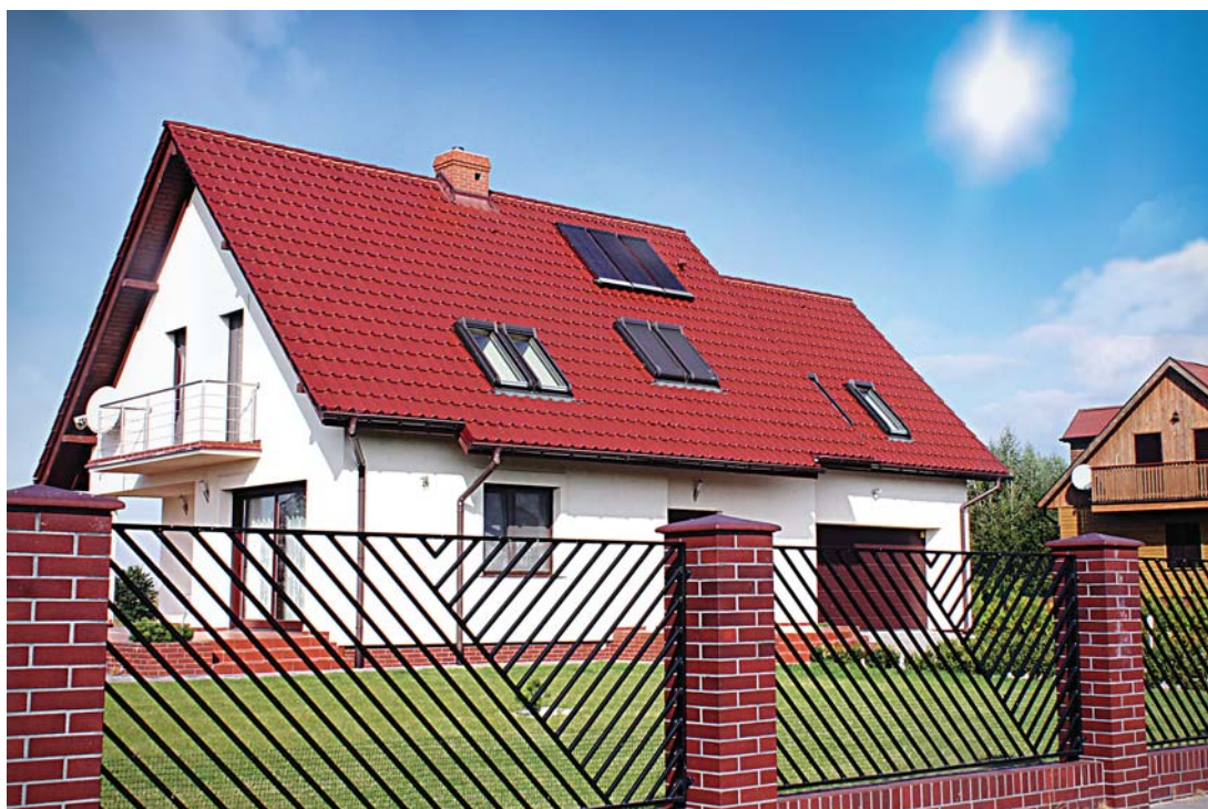
Rys. 1. Standardową sytuacją w eksploatacji instalacji solarnej jest wyjazd mieszkańców domu na urlop letni i związany z tym brak poboru ciepłej wody użytkowej
