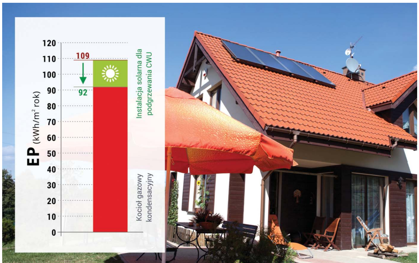
Rys. 3. Przykład obniżenia zużycia energii pierwotnej w budynku o powierzchni 140 m 2 wykonanym w standardzie izolacji cieplnej zgodnym z warunkami WT 2017, ogrzewanym kondensacyjnym kotłem gazowym
