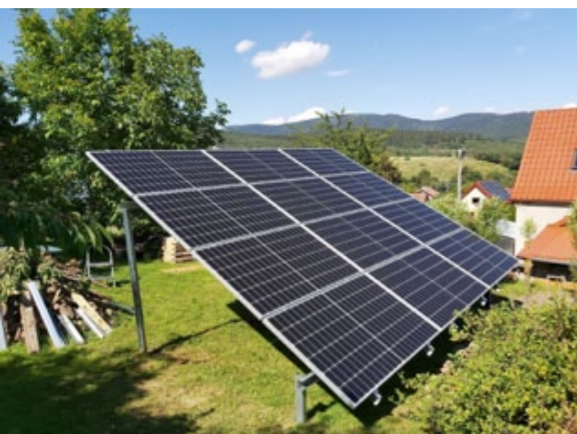
Popularnym rozwiązaniem stają się mocowania na gruncie. W ofercie znajduje się wersja 1- oraz 2-podporowa. Elementy konstrukcji pokryte są wysokowytrzymałą warstwą antykorozyjną Magnelis®. Bezpośrednio przy panelach można zbudować także inwertery Solis z obudową pyło- i wodoszczelną (fot. Roman Głaz)
